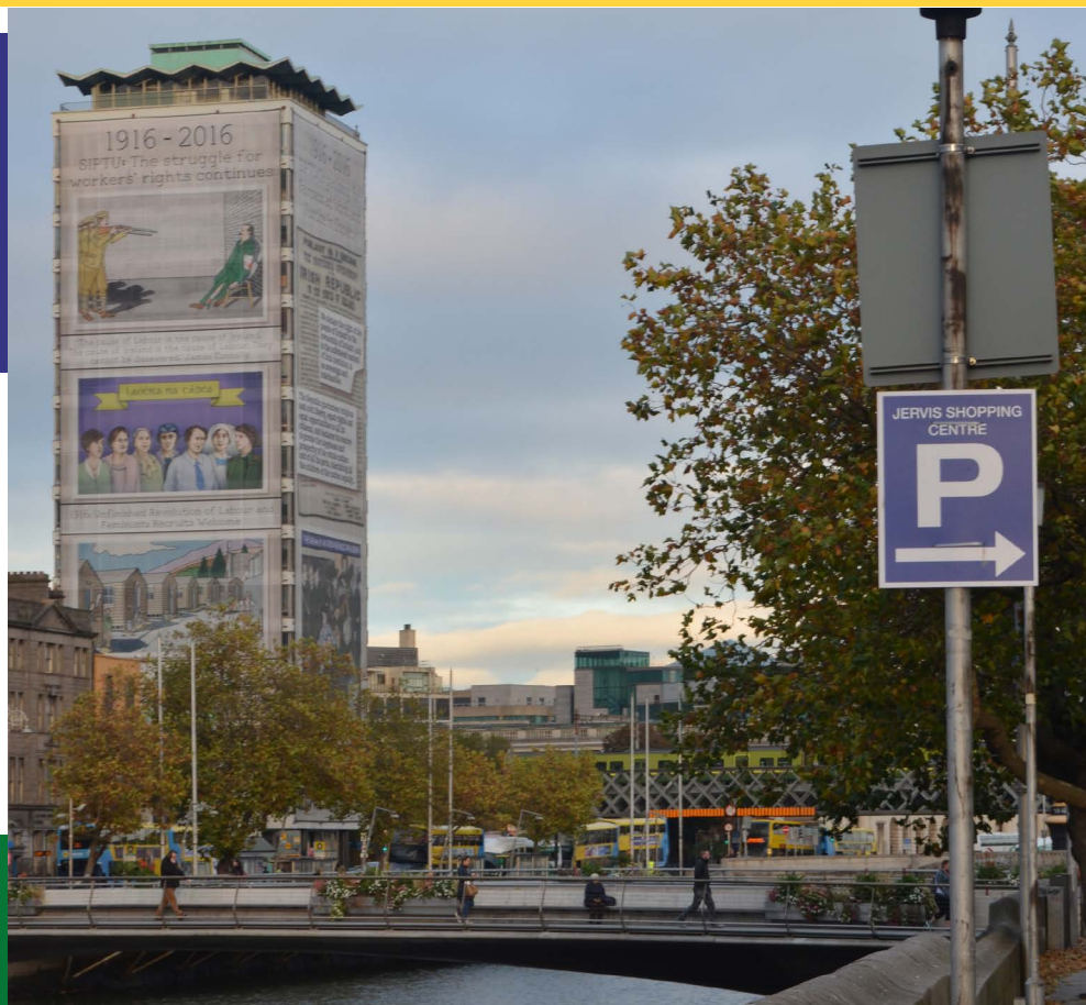
Edificio SIPTU (Gremio de Servicios Industriales, Técnicos y Profesionales) Fotografía tomada del otro lado del río Liffey. Dublín, noviembre de 2016. Centenario del Levantamiento de Pascua. Crédito: Romina Toledo
